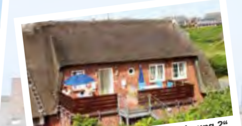
Komfort „Wohnung 1“ und „Wohnung 2“ im OG des Reethauses Strandweg 8 bis 2 bzw. 4 Personen
